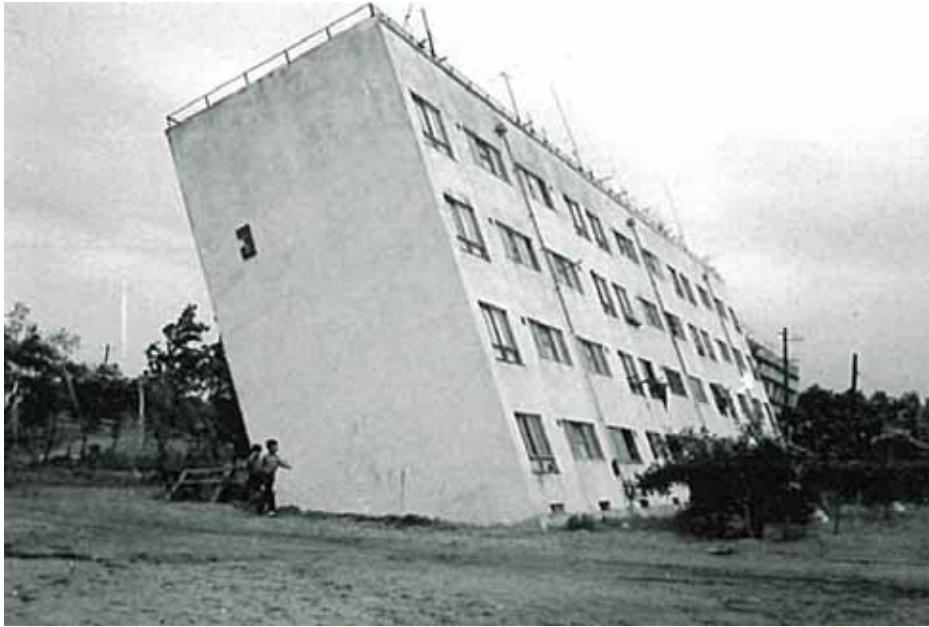
アパートの傾倒
